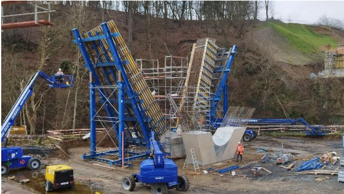
Zeitlich entkoppelt für mehr Effizienz: Während der Beton des einen V-Astes aushärtet (links), wird der andere für die Betonage vorbereitet (rechts). Foto: LBM Rheinland-Pfalz
